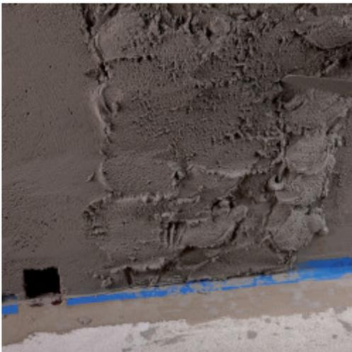
11. Dopo aver applicato il prodotto impermeabilizzante MAPEI secondo le indicazioni contenute nella relativa Scheda Tecnica, incollare la pavimentazione ed infine, stuccare le fughe
