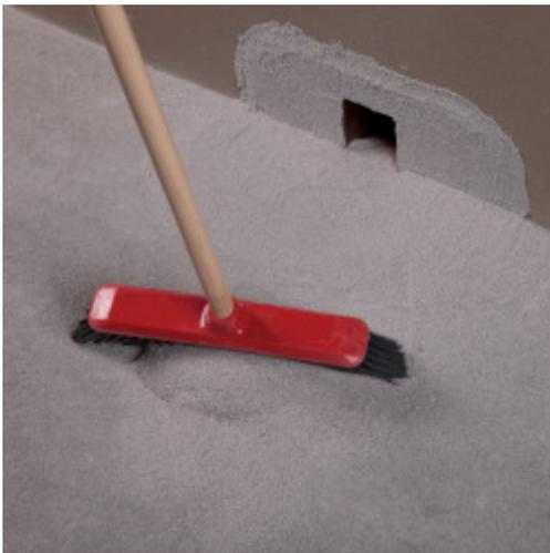
7. Nel raccordo tra orizzontale e verticale applicare un primo strato uniforme del prodotto impermeabilizzante MAPEI scelto, su sottofondo pulito ed asciutto
