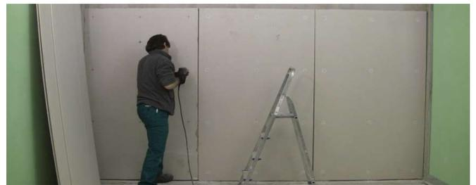
**5** Fissare la seconda lastra di cartongesso con la colla e/o con le apposite viti
