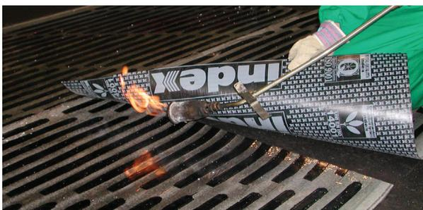
Posa a fiamma delle sormonte laterali e sormonte di testa in modo da garantire una perfetta sigillatura nei confronti del passaggio del vapore
