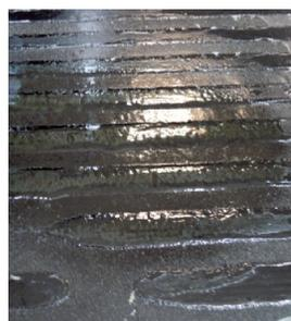
Insistendo con la sfiammatura, le strisce termodesive assumeranno una consistenza semilucida e lucida: **la superficie sarà pronta a ricevere la posa dei pannelli o rotoli di isolante**
