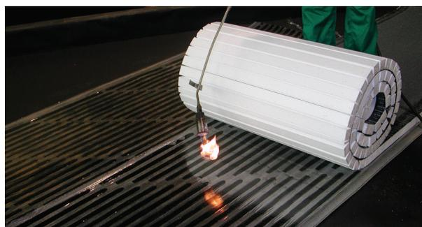
I rotoli di THERMOBASE srotolati sulla superficie appena sfiammata verranno fatti aderire al TECTENE BV STRIP EP mediante pressatura su tutta la superficie del rotolo mediante semplice calpestio dell'operatore (da effettuarsi su tutta la superficie del pannello o rotolo)
