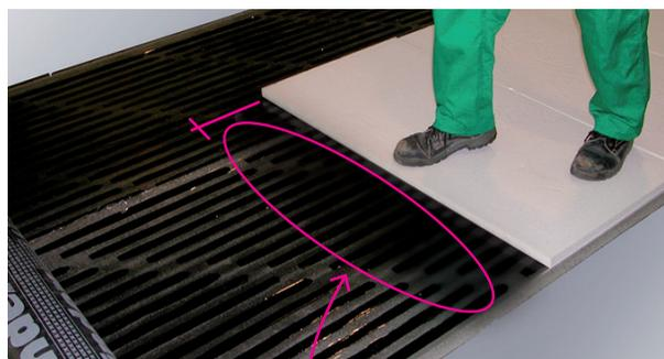
I pannelli di isolante adagiati sulla superficie appena sfiammata verranno fatti aderire al TECTENE BV STRIP EP mediante pressatura per semplice calpestio dell'operatore (da effettuarsi su tutta la superficie del pannello)
