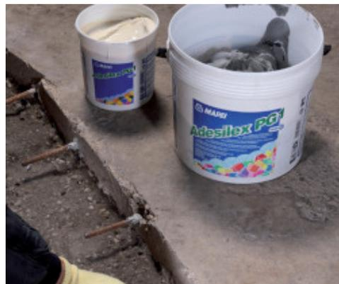
Fissaggio dei ferri per la spinottatura con Adesilex PG
