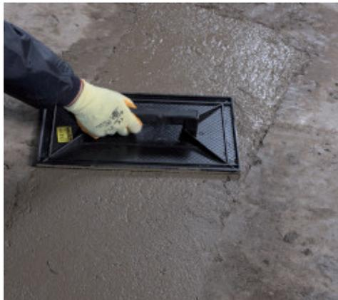
Frattazzatura di Mapegrout SV Fiber
