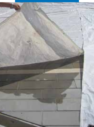
Esempio di protezione della pavimentazione
