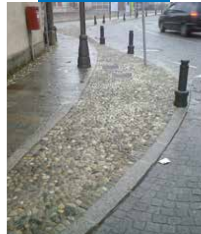
Esempi di posa in acciottolato, lastrame e cubetti di portido
