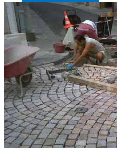
Esempio di posa ad arco
