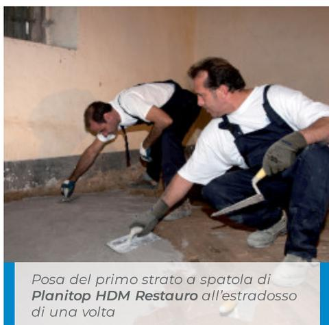
Posa del primo strato a spatola di **Planitop HDM Restauro** all'estradosso di una volta
