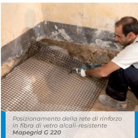
Posizionamento della rete di rinforzo in fibra di vetro alcali-resistente **Mapegrid G 220**
