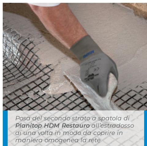
Posa del secondo strato a spatola di **Planitop HDM Restauro** all'estradosso di una volta in modo da coprire in maniera omogenea la rete
