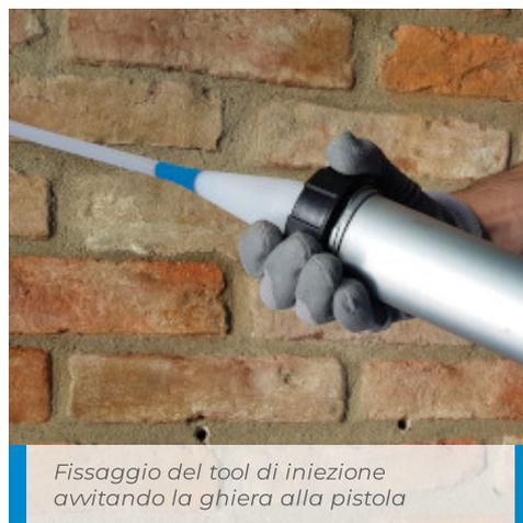
Fissaggio del tool di iniezione avvitando la ghiera alla pistola
