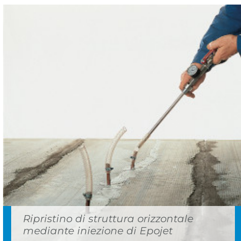
Fissaggio degli iniettori con Adesilex PG1
