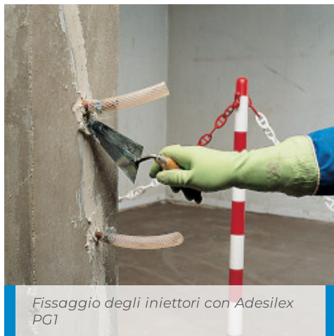
Iniezione di Epojet in pilastro fessurato
