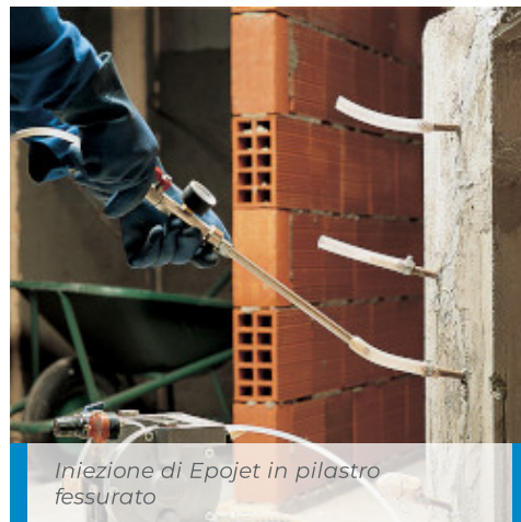
Fissaggio degli iniettori con Adesilex PG1
