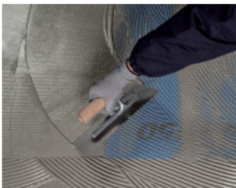
Inserimento di Mapenet 150 nella prima mano di Mapelastic Turbo fresca
