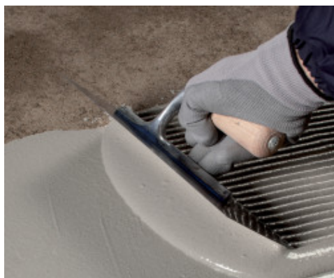
Applicazione della prima mano di Mapelastic Turbo
