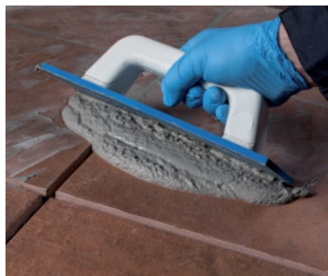
Stuccatura di piastrelle con Ultracolor Plus
