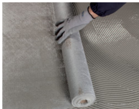
Inserimento di Mapetex Sel nella prima mano di Mapelastic Turbo fresca
