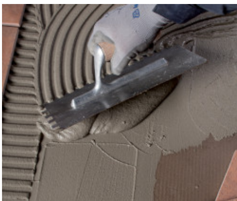
Posa di piastrelle con Elastorapid
