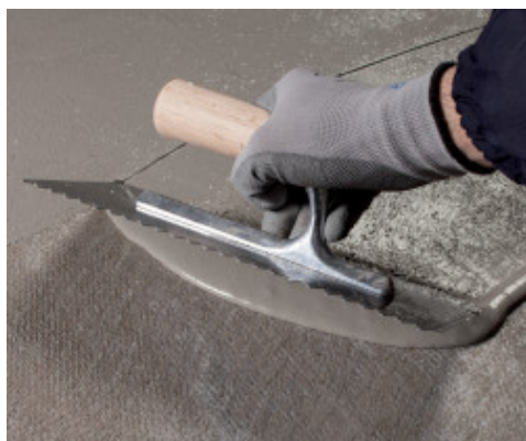
Seconda mano di Mapelastic Turbo su prima armata con Mapetex Sel
