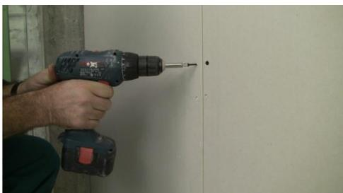
Fissare la seconda lastra di cartongesso con la colla e/o con le apposite viti
