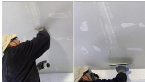
Applicare il nastro in rete nelle giunzioni delle lastre. Stuccare le giunzioni
