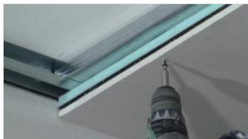
Fissare il pannello ai profili metallici con viti da 55 mm ogni 15 cm
