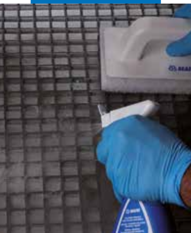
Nebulizzazione di Kerapoxy Cleaner sulla superficie da pulire
