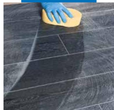
Pulizia e finitura delle fughe con spugna di cellulosa dura
