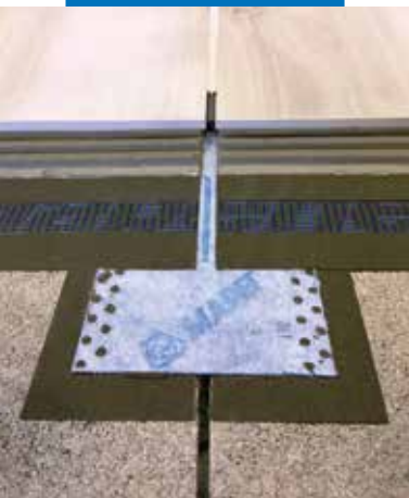
Mapeband Easy posato in corrispondenza di un giunto di controllo del massetto
