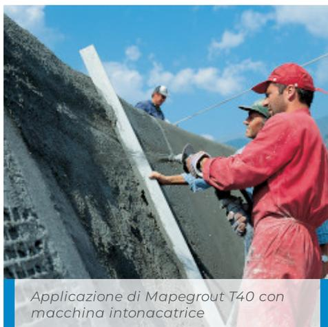
Applicazione di Mapegrout T40 con macchina intonacatrice
