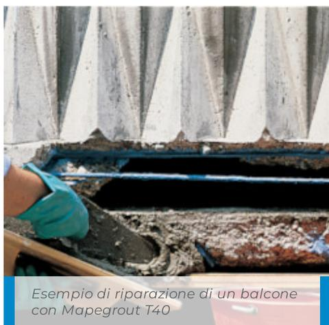
Esempio di riparazione di un balcone con Mapegrout T40
