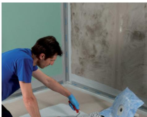
Applicazione di Drain Vertical mediante Mapegum WPS
