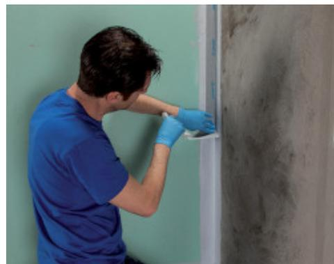
Applicazione di Mapeband PE 120 mediante Mapegum WPS
