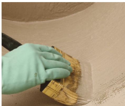
Impermeabilizzazione di dettagli a pennello
