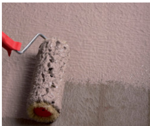
Impermeabilizzazione di terrazzo a rullo
