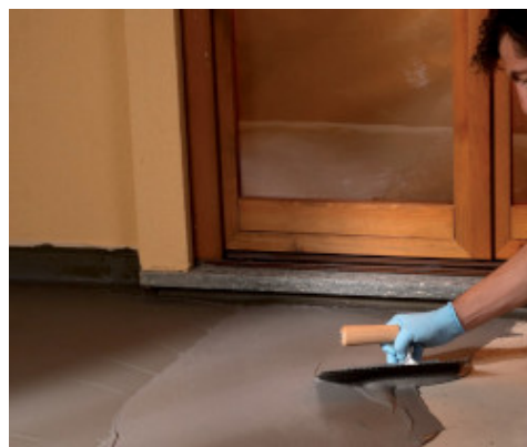
Impermeabilizzazione di terrazzo a spatola
