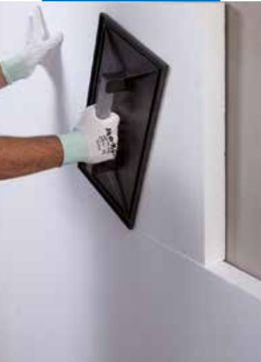
Pressatura del pannello durante la posa, necessaria per garantire la corretta adesione al supporto
