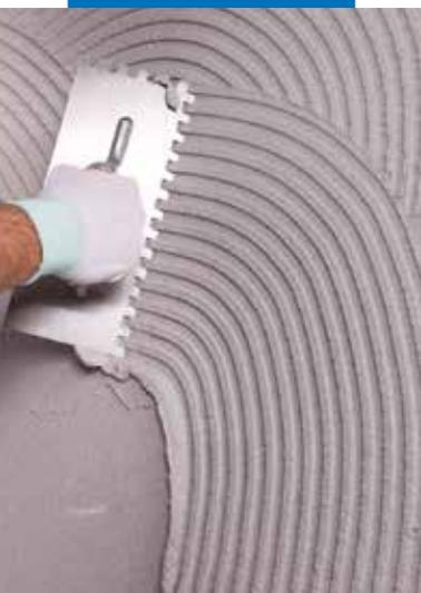
Stesura della prima mano di rasatura con Mapetherm AR1 GG
