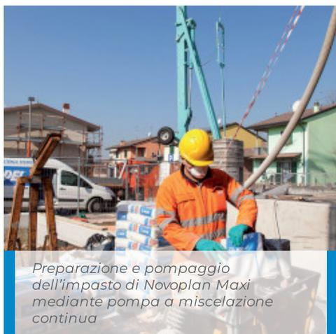
Preparazione e pompaggio dell'impasto di Novoplan Maxi mediante pompa a miscelazione continua
