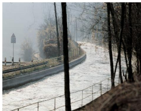
Canale idroelettrico Bertini - Robbiate (CO). Esempio di trattamento superficiale con Planiseal 88
