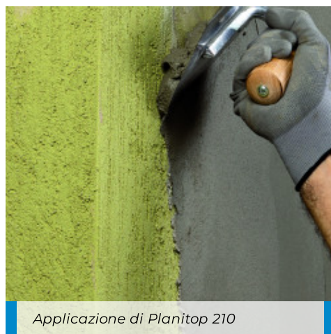
Frattazzatura di Planitop 210
