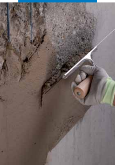
Applicazione a spatola di Planitop Rasa & Ripara
