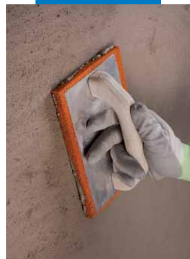
Frattazzatura di Planitop Rasa & Ripara
