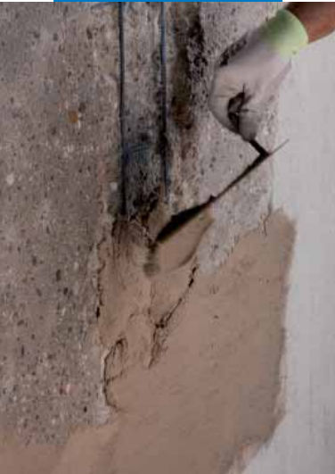
Applicazione a cazzuola di Planitop Rasa & Ripara
