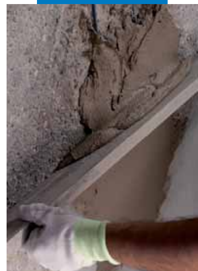
Staggiatura di Planitop Rasa & Ripara
