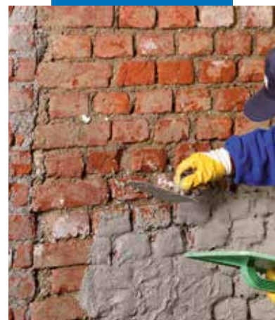
Applicazione di Poromap Rinzafo Plus a cazzuola
