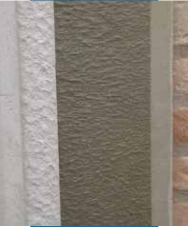
Applicazione di PoroMap Rinzafo Plus su Mapelastic Foundation per la realizzazione del ciclo anticondensa
