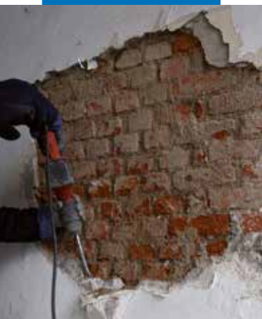
Rimozione dell'intonaco degradato
