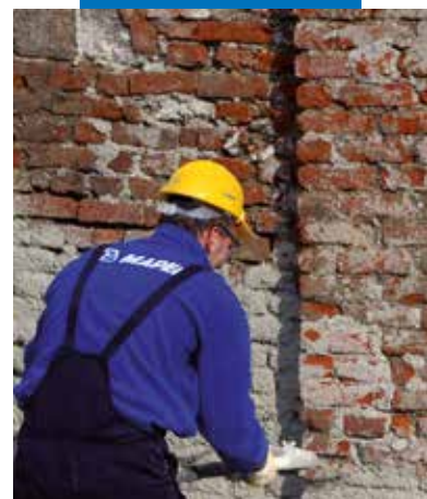
Applicazione di Poromap Rinzafo Plus con intonacatrice
