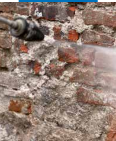
Idrolavaggio della muratura
